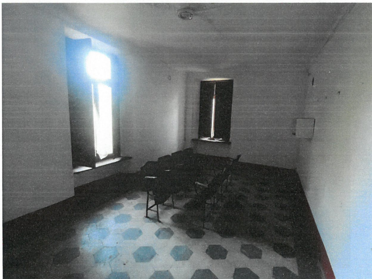
Foto – Locale piano primo
