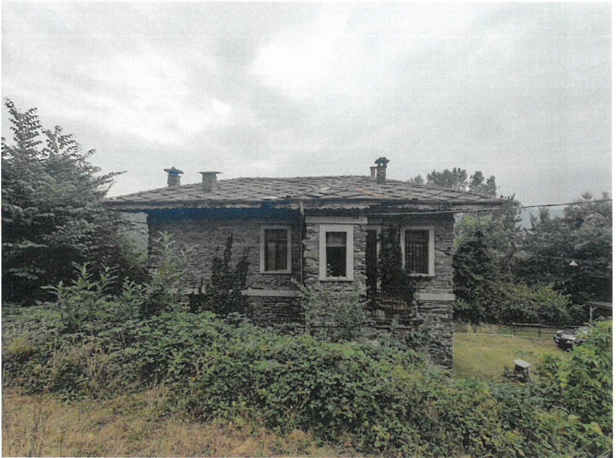
Foto – Prospetto ovest
