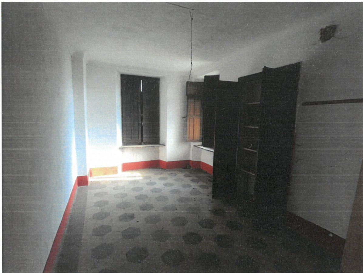
Foto – Locale piano primo
